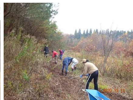
イノシシに荒らされた散策路の整地
